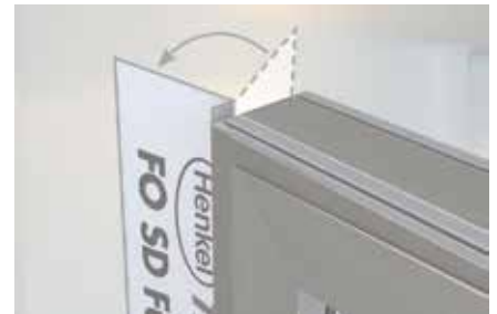
2 Folie im Bereich des Hotmelt freien Streifens umlegen und Blendrahmen im Mauerwerk befestigen.
