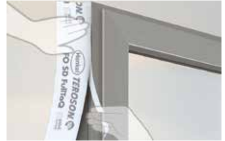
1 Schmalen Streifen des Trennpapiers abziehen und Folie am Blendrahmen positionieren. Folie mit Hilfe einer Hartgummirolle andrücken.
