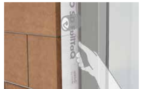
4 Folie mit Hilfe einer Hartgummirolle auf dem Mauerwerk andrücken.
